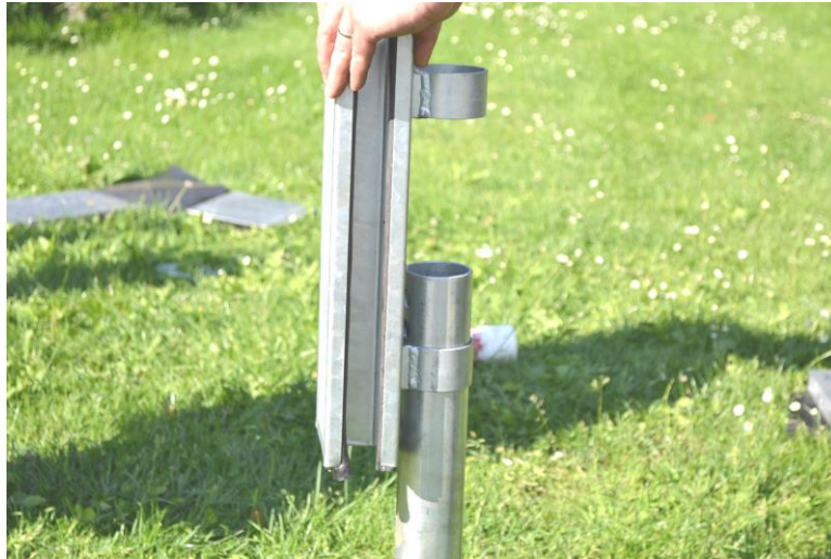
Obr. 1.6: Nasadenie úložného dielca na stĺpik
