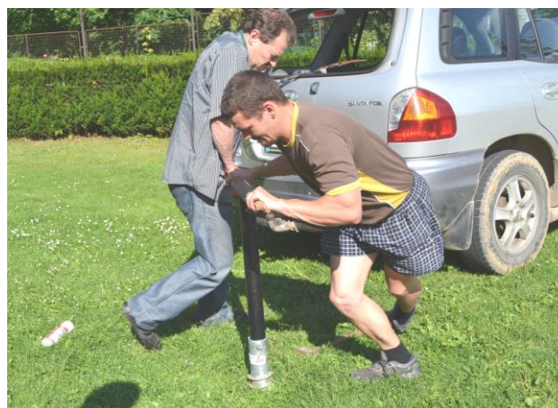
Obr. 1.3: Zavrtávanie zemnej kotvy
