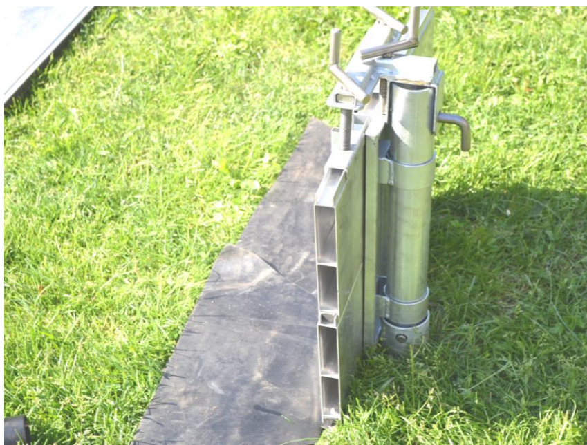
Obr. 1.9: Uloženie panela do kapsy
